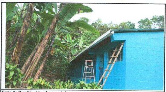
Foto 5: Sustitución de canal de pvc.
