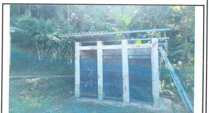
Foto 4: Sustitucion de puerta de baño.
