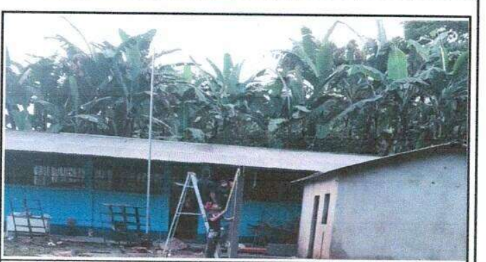
Foto 6: Sustitucion de canal de pvc.
