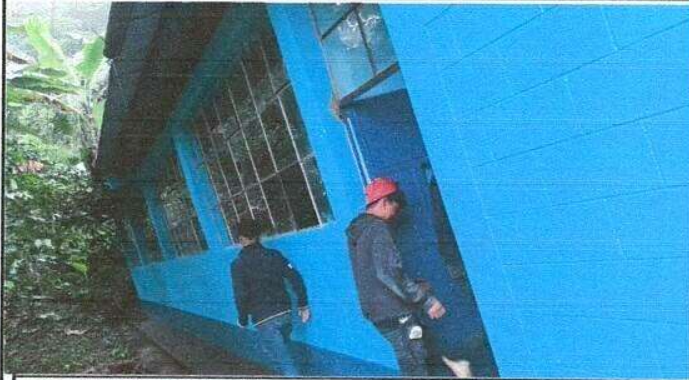
Foto1: Sustitución de vidrios.
