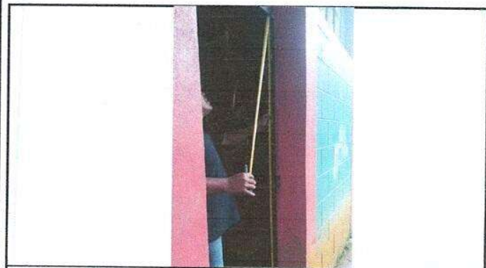
Foto 3: Sustitución de puerta grande
